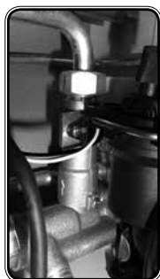
Датчик расхода в сборе Basic (до 2015г.)
