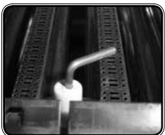
Электрод розжига/ионизации котлов серии Basic , Basic Duo (по 2015г.)
